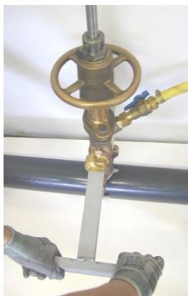
1-Déverrouiller et dégager l'arbre
