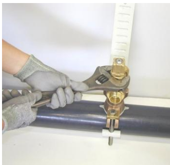
6-Serrer l'écrou de manœuvre
