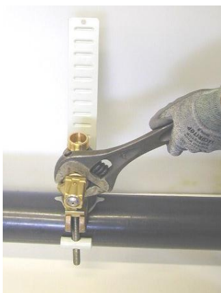
5-Dévisser l'ensemble de manœuvre et le réinstaller sur le dessus du robinet
