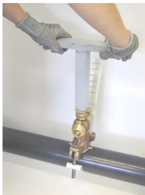
7-Réaliser une brève opération d'ouverture / fermeture pour évacuer les éventuels copeaux restant (chasse copeaux)
