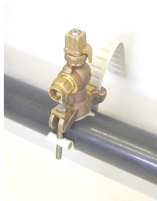
8- Positionner le raccord sur la sortie du robinet
