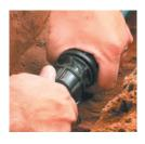
4. Serrer jusqu'au contact entre l'écrou et l'épaulement sur le corps du raccord.
