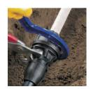
4. Serrer à l'aide de la clef dédiée. Note: l'écrou n'arrive pas en butée sur l'épaulement avec les tubes de diamètre proche de la tolérance supérieure ; le raccord est en place lorsqu'il n'est plus possible de serrer outre mesure.
