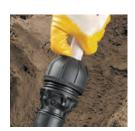
3. Insérer le tube jusqu'à la profondeur repérée.
