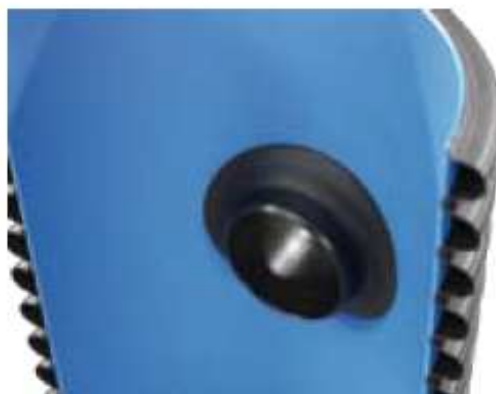
Vue de l'intérieur de la canalisation
