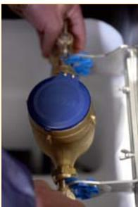
2. Clipsage des éléments de robinetterie sur le rail de compteur
