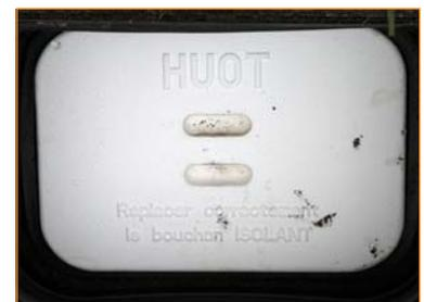
5. Avant fermeture du tampon, replacer le bouchon isolant correctement.
