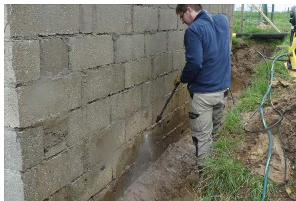
FIGURE N°5 : DÉCAPAGE DES SURFACES À L'AIDE D'UN NETTOYEUR HAUTE PRESSION
