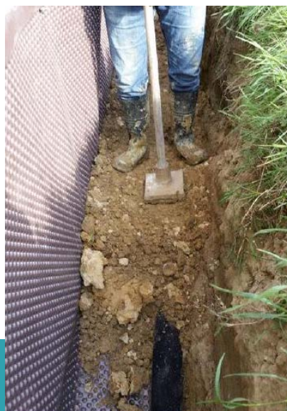
FIGURE N°32 : DAMMAGE MANUEL DES COUCHES DE REMBLAIS
