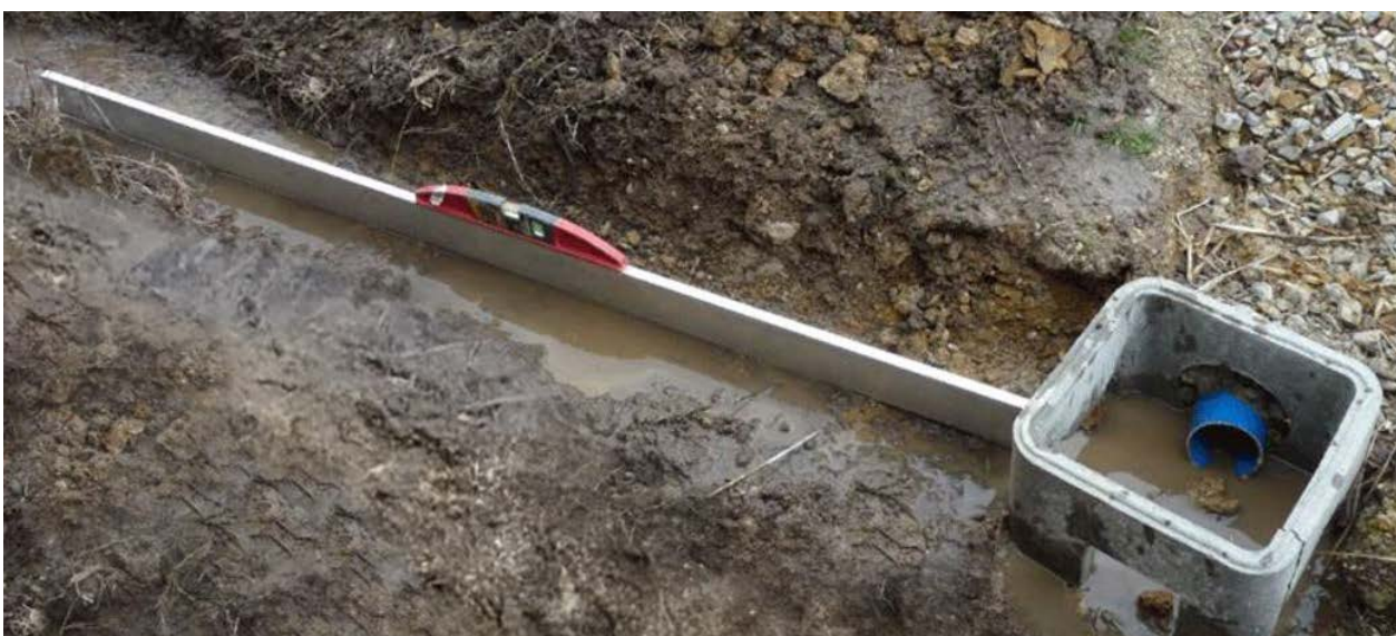
FIGURE N°14 : VÉRIFICATION DES PENTES AVANT LA MISE EN OEUVRE DU DRAIN BATIFIBRE® À DISTANCE DES FONDATIONS
