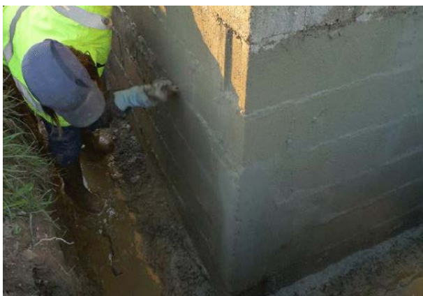
FIGURE N°12 : MISE EN OEUVRE D'UN PRODUIT D'ÉTANCHÉIFICATION
