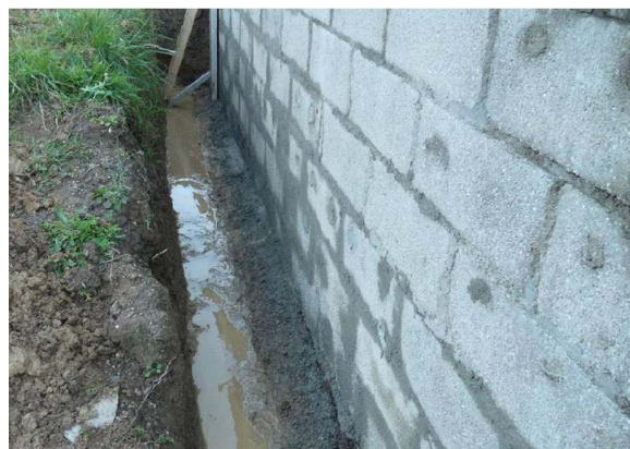
FIGURE N°6 : REJOINTOIEMENT DES PAREMENTS DES FONDATIONS
