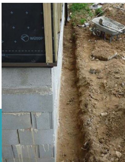
FIGURE N°9 A : NETTOYAGE ET ÉLARGISSEMENT DE LA TRANCHEE
