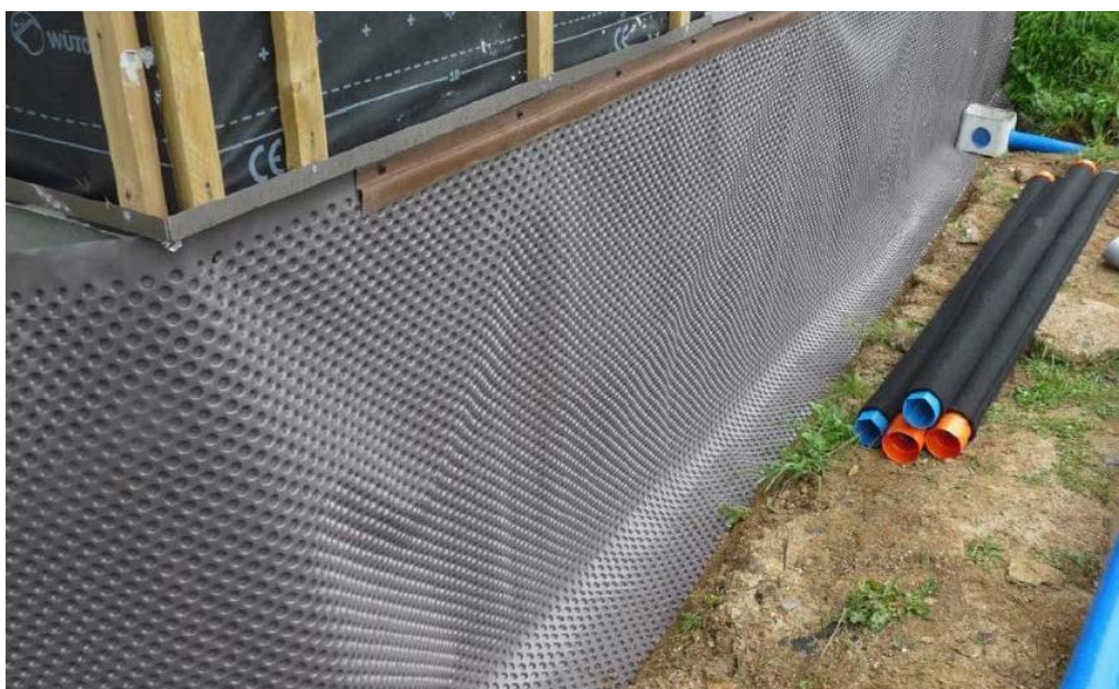
FIGURE N°13 : MISE EN OEUVRE D'UN FILM GAUFRE POUR PROTECTION DE L'ÉTANCHÉITÉ
