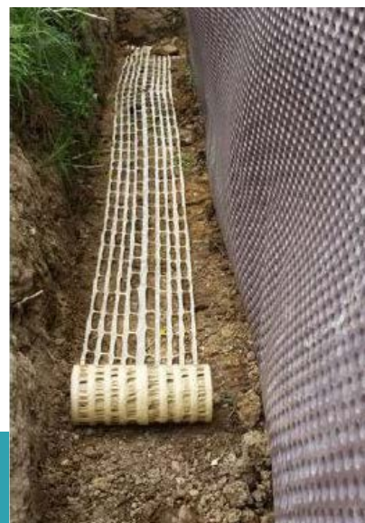
FIGURE N°33 : MISE EN OEUVRE D'UN GRILLAGE AVERTISSEUR
