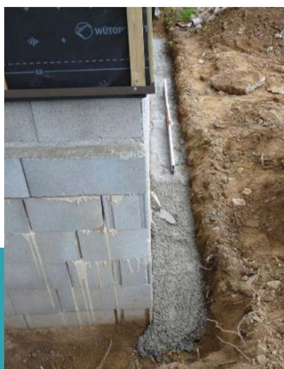
FIGURE N°9 B : RÉALISATION DE LA CUNETTE EN BETON MAIGRE & VÉRIFICATION DES PENTES
