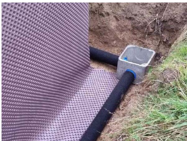
FIGURE N°18 : CHANGEMENT DE DIRECTION AVEC UNE BOITE D'INSPECTION
