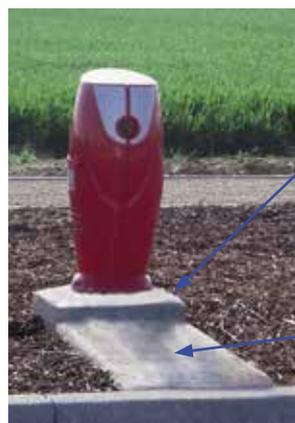
Socle d'ancrage permettant une mise à niveau future du sol fini.
