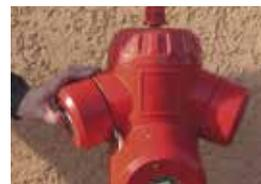
**3** - Si le poteau n'est pas en pression, placez-vous derrière le poteau et enlevez un bouchon pour raccorder une manchette souple, et éventuellement le matériel que vous souhaitez alimenter.
