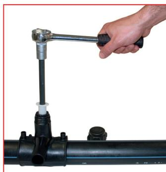
**5 Mettre en place** la prise de branchement, serrer les boulons pour positionner la prise. Pour les prises FASTCLAMP, le bon positionnement est atteint lorsque les cylindres sont en contact ferme par serrage de la poignée à la main. Les extrémités opposées des tubes sont fermées à l'aide de protections, les courants d'air pouvant être à l'origine d'effets cheminée.
