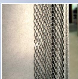
1 Fixer le profilé à sec et mécaniquement tous les 50 cm sur les plaques de plâtre.
