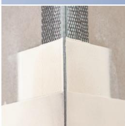
3 Après séchage, utiliser un enduit de finition tout usage pour une couche d'enduit minimale de 1mm.
