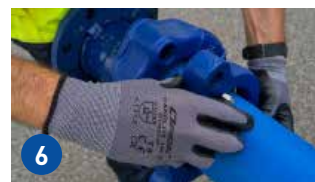
6 PLAQUER LA CONTRE-BRIDE D'ÉTANCHEITÉ SUR LE JOINT EXPRESS®, PUIS LA CONTRE BRIDE DE VERROUILLAGE
