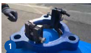
1 METTRE EN PLACE LE COLLIER DE VERROUILLAGE DANS LA CONTRE BRIDE DE VERROUILLAGE
