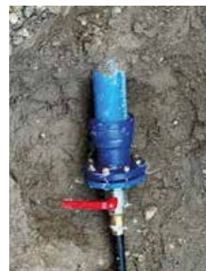
Assemblage d'extrémité point haut (Purge de l'air)
