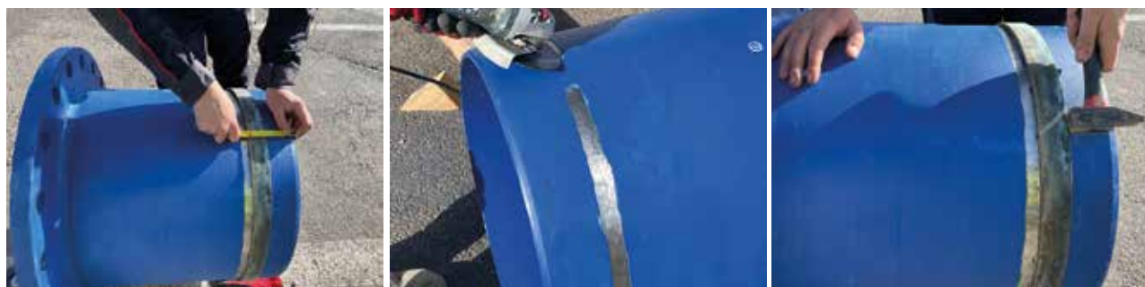
Exemple avec un tuyau revêtu d'une peinture époxy
