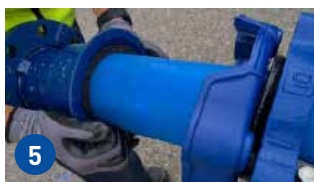
5 POUSSER LE JOINT EXPRESS® DANS L'EMBOÎTEMENT DU RACCORD EXPRESS®
