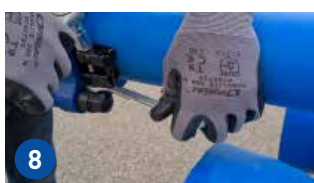
5 POUSSER LE JOINT EXPRESS® DANS L'EMBOÎTEMENT DU RACCORD EXPRESS®
