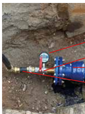
Assemblage d'extrémité point bas (remplissage d'eau et lecture du manomètre)
