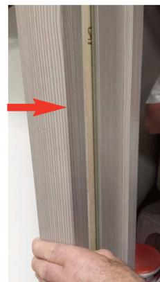
8/ Procéder aux réglages d'aplomb et d'équerrage, vérifier le bon fonctionnement de la porte
