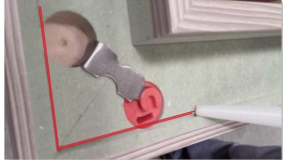
5/ Positionner le 1er encadrement sur la cloison : montant « A » coté « butée de porte fermée ».
