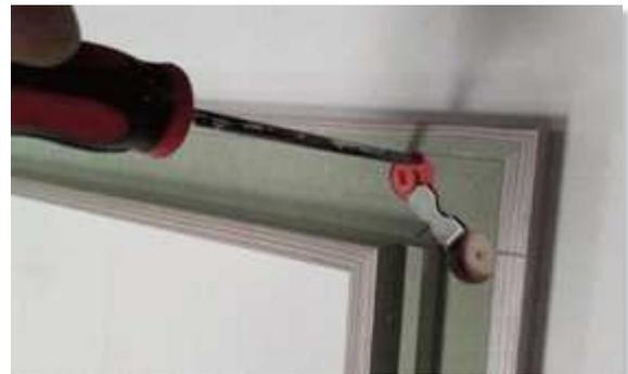
3/ Vérifier le bon assemblage de chaque coupe, au besoin desserrer, ajuster et resserrer l'excentrique.
