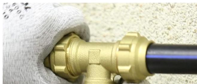
7-Visser fermement l'écrou pousseur jusqu'à la butée de filet du raccord. De 2 à 3 tours selon le DN du raccord
