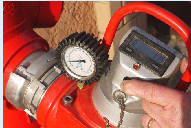
3 - Contrôle de la pression à 60 m 3 /h
