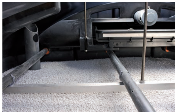
média en place
