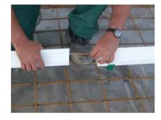
**13.**Il est aussi conseillé d'utiliser une chute d'acier que l'on insère dans les parties creuses de la règlejoint TOFFOLO.
