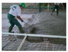
**17.**On procède bloc par bloc ou par couloir de coulage (utilisation de la règle-joint modèle 40 à planter pour fractionner dans le sens transversal).
