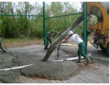
**16.**Une fois les règle-joints installées, on effectue un dernier contrôle de niveau sur les profilés et on peut immédiatement passer au coulage. Il peut s'effectuer à la pompe à béton ou directement avec le camion toupie.
