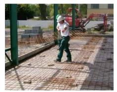
Compactage du sol et mise en place des treillis soudés (sur espaceurs)
