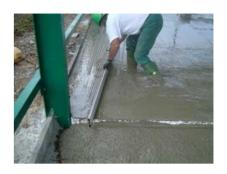
**18.**On tire le béton sur les profilés sans se soucier du niveau du dallage car il est défini par le sommet des règles-joints.
