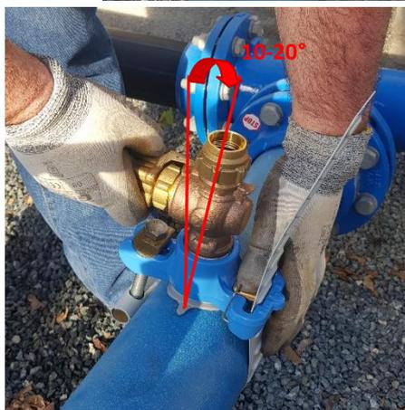
6-Incliner légèrement l'ensemble vers l'arrière (d'environ 10 à 20°) pour anticiper l'inclinaison générée au fur et à mesure par le serrage de la vis et effectuer le positionnement du système en deux temps. (Approche et finalisation)
