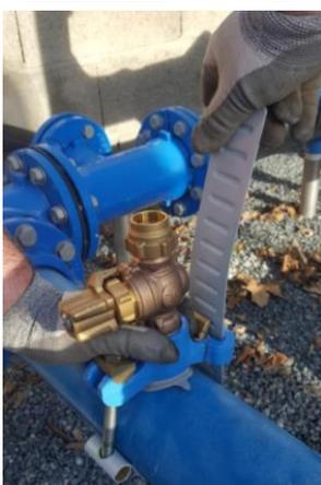
3-Tirer sur l'extrémité de la sangle et abaisser le cliquet dans le cran correspondant à la tension maximum, tout en maintenant la rotule de vis dans son logement.
