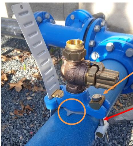
1-Serrer la vis jusqu'à obtenir la stabilité du système sur la canalisation (pour réaliser le percement) jusqu'à avoir un point de contact avec collerette grise
