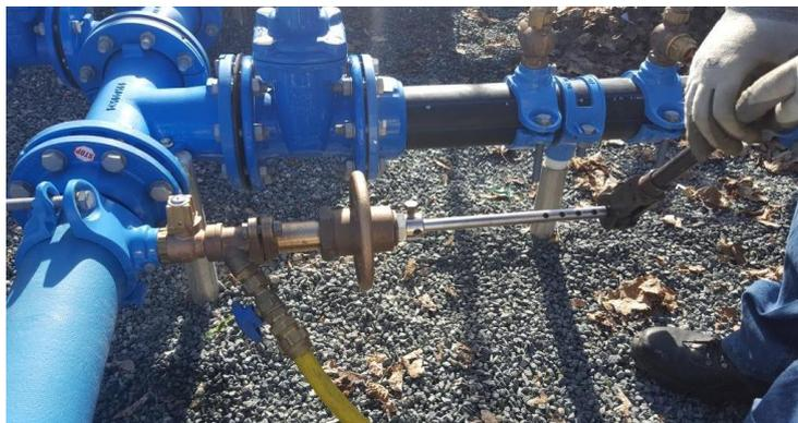
1-Déverrouiller la vis pointeau, dégager et remonter l'arbre
