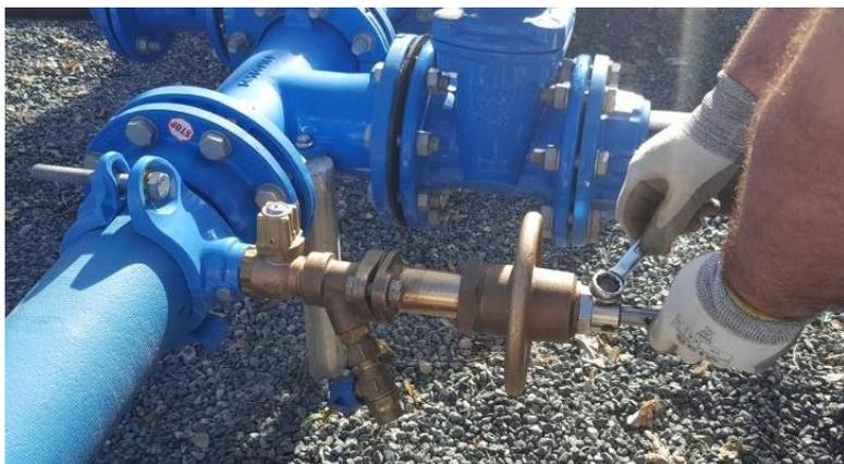
5-Raccorder le tuyau d'évacuation et ouvrir le robinet de purge
