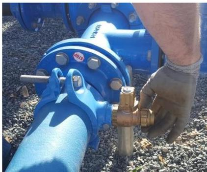
7-Raccorder le tuyau de branchement au robinet (voir préconisation de mise en œuvre du raccord U-CAN)
