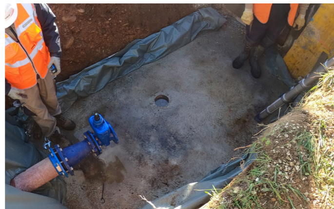
Sous Chaussée : un radier béton est obligatoire
