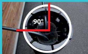
Pour orienter les PE, il faut que les écrous des raccords soit desserrés
