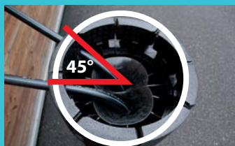
Pour orienter les PE, il faut que les écrous des raccords soit desserrés
