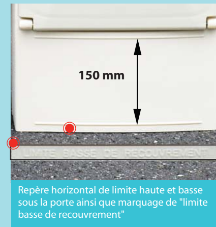
Porte verrouillable avec une clé triangle à ergots (la porte ne peut toucher le sol) . Coffret beige (standard EDF) et auto nettoyant
