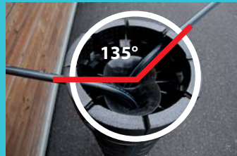
Pour orienter les PE, il faut que les écrous des raccords soit desserrés
