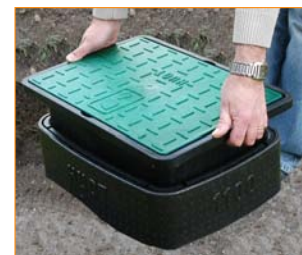
5. Compactage et ajustement du cadre plastique
