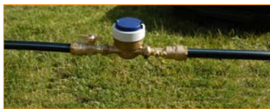
1. Montage de la robinetterie avant compteur, du compteur et du clapet.
