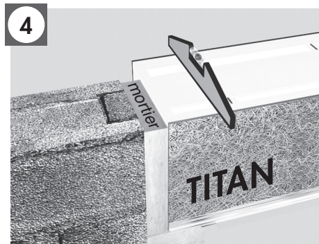
Bourrer les 2 extrémités de mortier. Pas de mousse!
