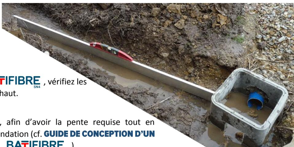
**FIGURE N°13 : VÉRIFICATION DES PENTES AVANT LA MISE EN ŒUVRE DU DRAIN BATIFIBRE<sup>SN4</sup> À DISTANCE DES FONDATIONS**
