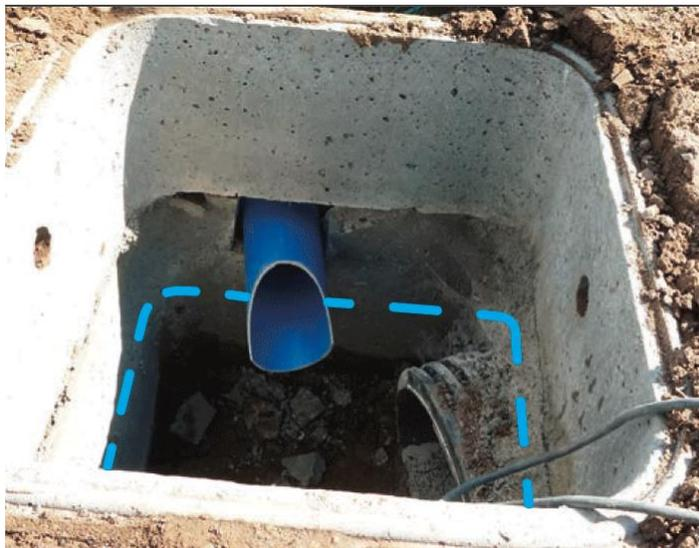
**FIGURE N°1 : CONNEXION DU RESEAU DE DRAINAGE A UN EXUTOIRE**
