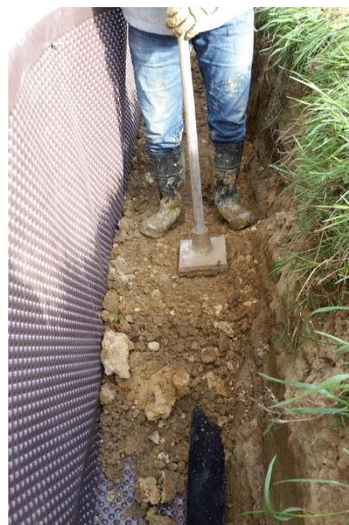
**FIGURE N°26 : DAMMAGE MANUEL DES COUCHES DE REMBLAIS**
