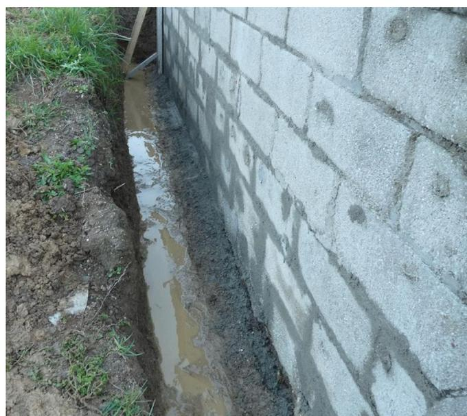
**FIGURE N°5 : REJOINTOIEMENT DES PAREMENTS DES FONDATIONS**
