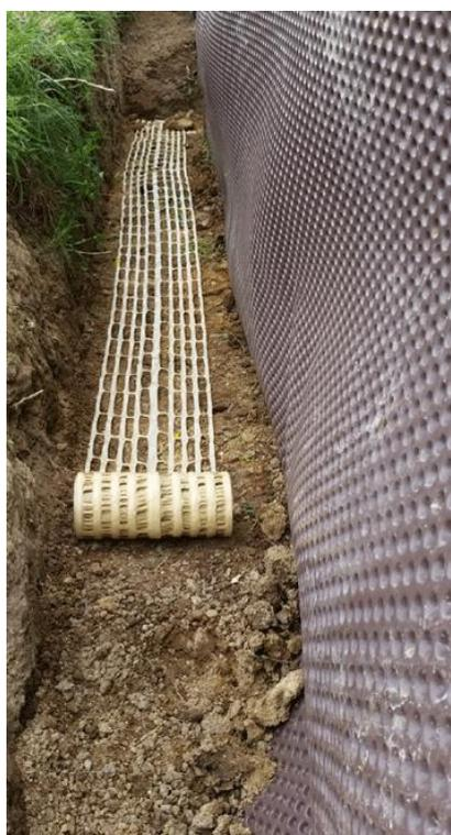
**FIGURE N°27 : MISE EN ŒUVRE D'UN GRILLAGE AVERTISSEUR**
