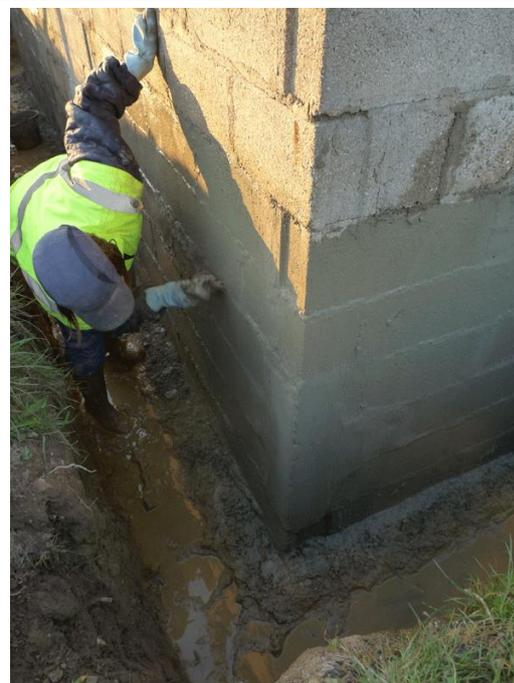
FIGURE N°11 : MISE EN ŒUVRE D'UN PRODUIT D'ETANCHEIFICATION
