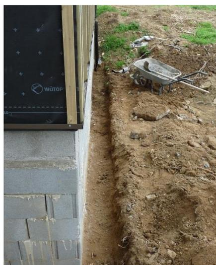
**FIGURE N°7 : NETTOYAGE ET ELARGISSEMENT DE LA TRANCHEE**
