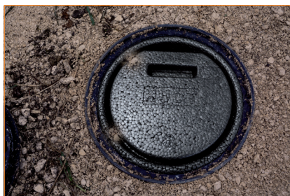
4. Avant fermeture du tampon, replacer le bouchon isolant correctement
