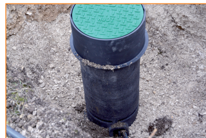
3. Compactage et ajustement de la réhausse
