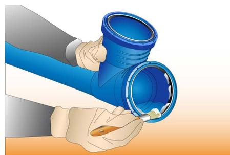
5 - Appliquer le lubrifiant sur le joint
