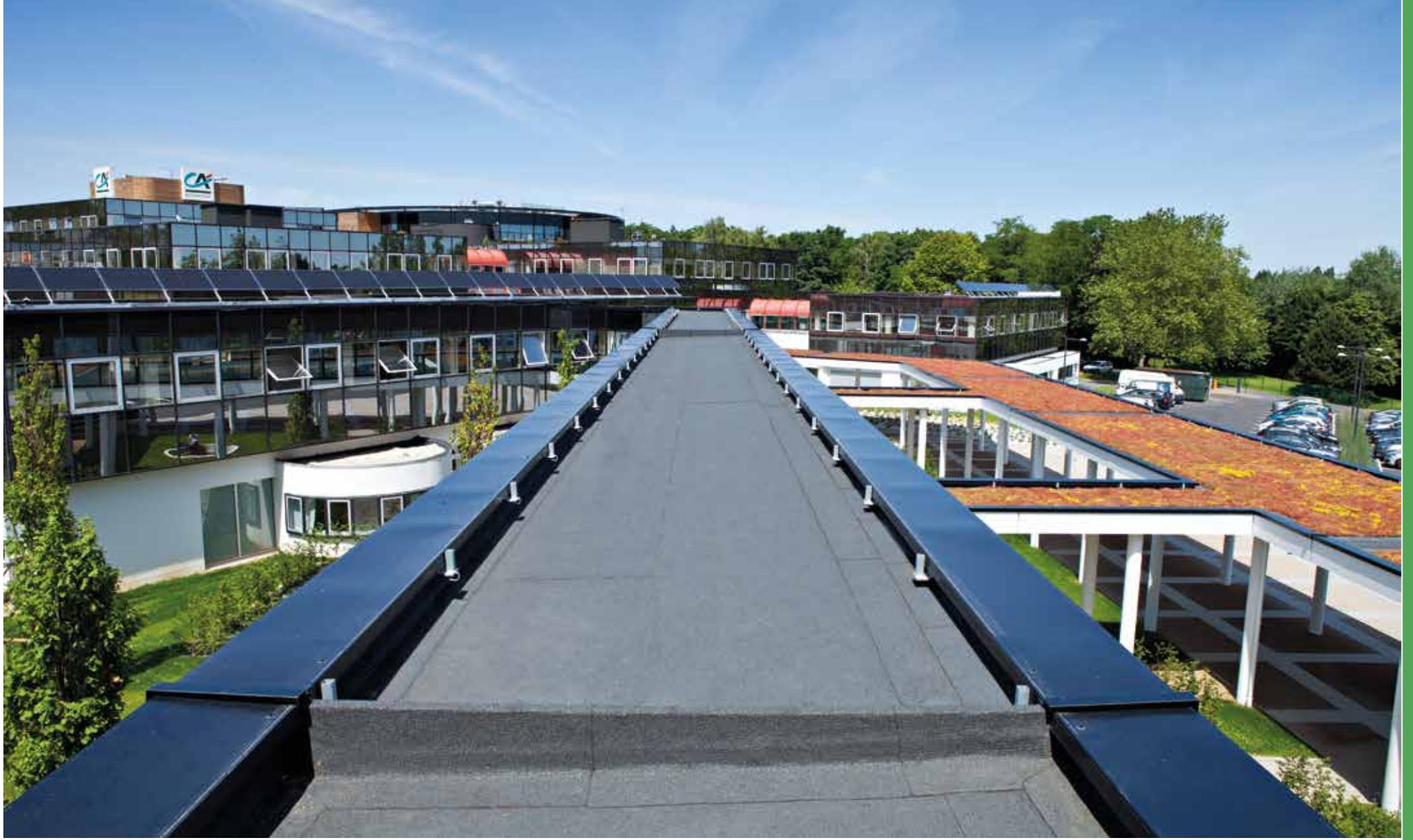
*Les membranes bitumeuses bio-sourcées*
