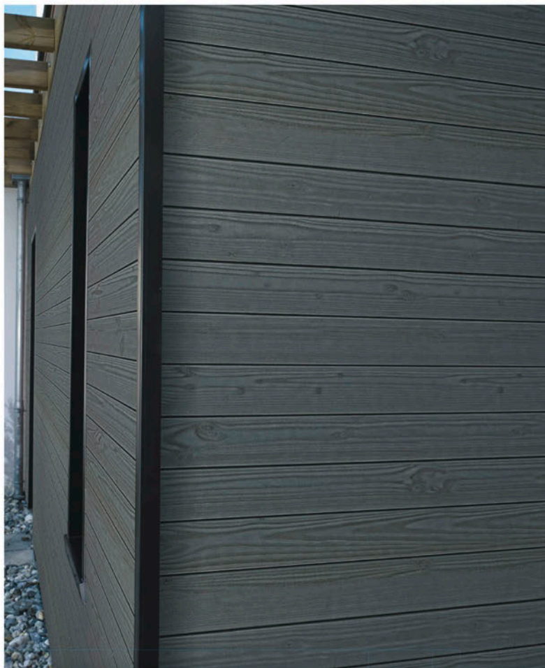
➔ Effets du vieillissement sur un bois non-protégé
