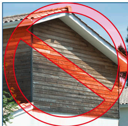
➔ Effets du vieillissement sur un bois non-protégé
