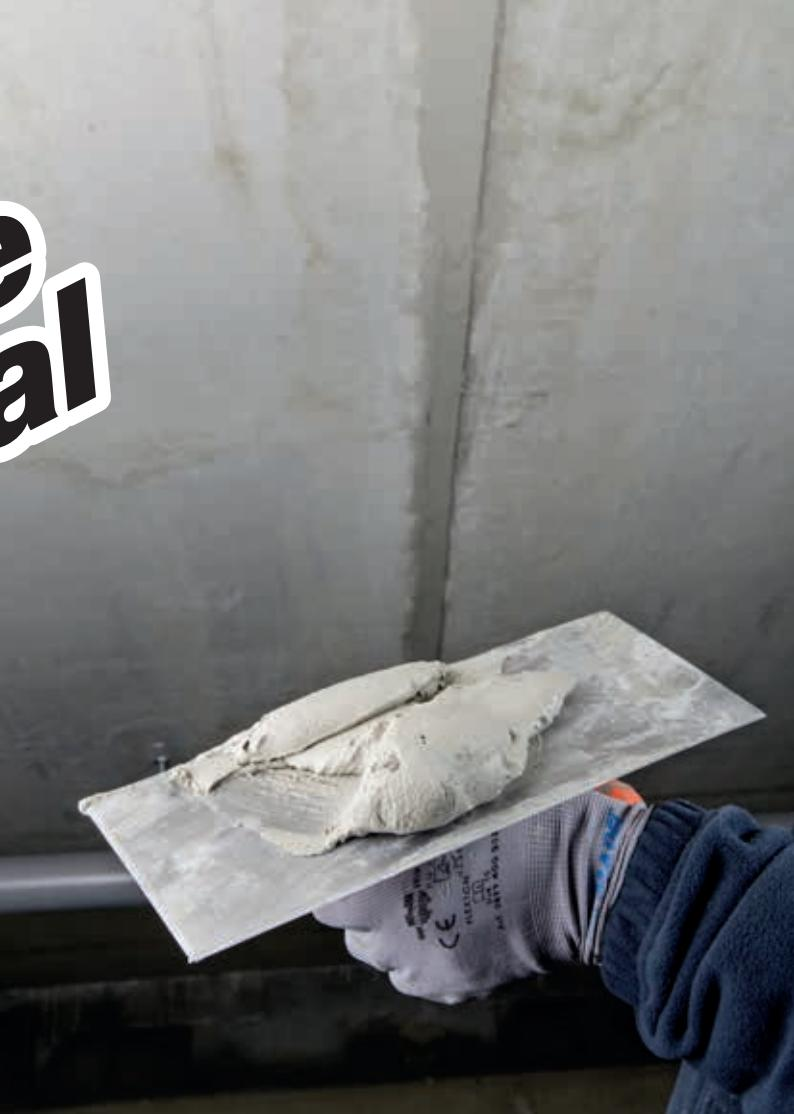
prémurs doivent être mis en œuvre conformément à leur Avis Technique ou Document Technique d'Application. Le bâtiment doit être hors d'eau, les étais de planchers enlevés et les cloisons lourdes posées. Les prédalles doivent être posées avec un espace de 5 à 15 mm entre bords verticaux. La largeur du joint à remplir doit être d'au moins 10 mm.
