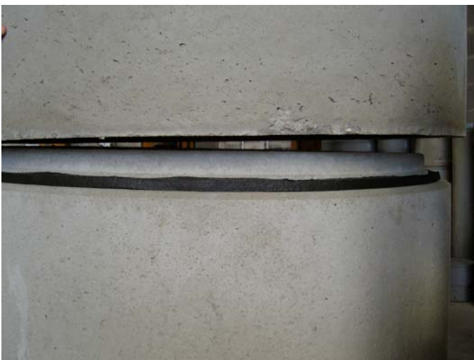
Mise en place dans l'about femelle
