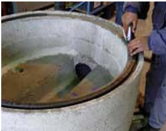
Mise en place dans l'about femelle
