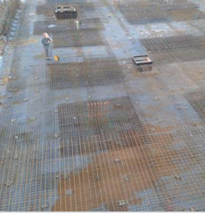
Résidence seniors, La Londe-les-Maures (F) ■ Application : drainage horizontal sous dallage ■ Surface : 2.500 m 2
