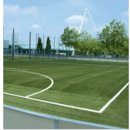
Terrains d'entraînement, Karlsruhe (All.) ■ Application : drainage de terrains sportifs ■ Surface : 5.000 m 2
