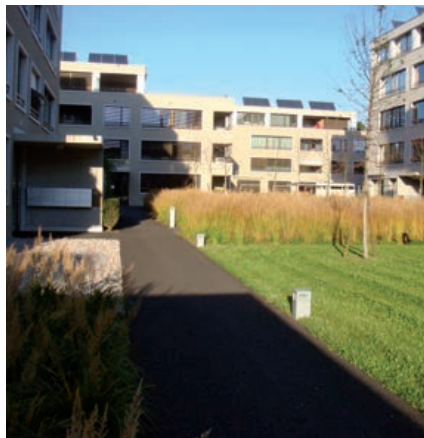
Complexe Ziegeleihof, Oberwil (Suisse) ■ Application : toiture-terrasse végétalisée sur parking souterrain ■ Surface : 1.800 m 2
