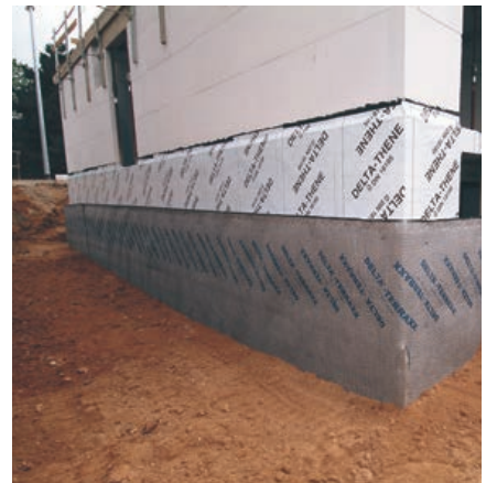
Maison d'habitation (F) ■ Application : paroi enterrée isolée ■ Surface : 120 m 2
