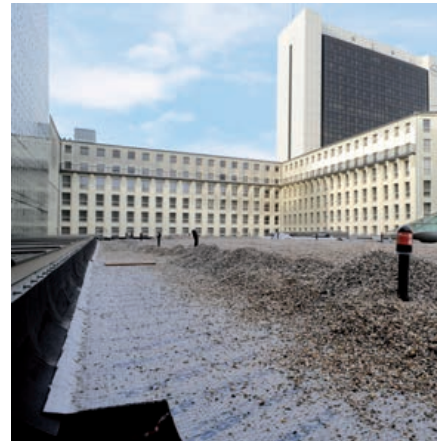
Bibliothèque Municipale, Berlin (All.) ■ Application : toiture-terrasse accessible ■ Surface : 2.000 m 2
