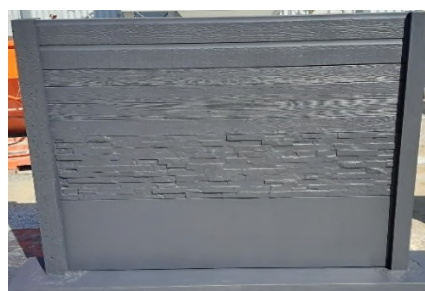
► Clôture écran après application du minéralisant teinté ton gris anthracite
