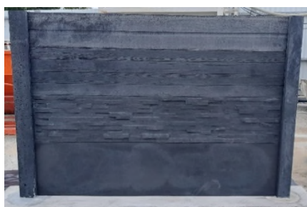
► Clôture écran avant application du minéralisant teinté ton gris anthracite
