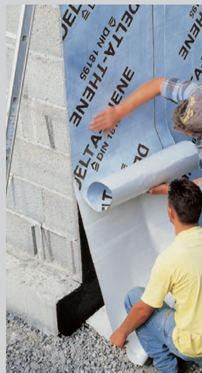
DELTA®-THENE rend la paroi instantanément étanche, sans séchage, et sans défaut.
