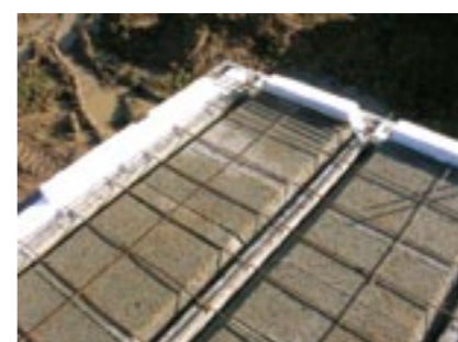
▲ 7 - Pose du treillis soudé Le treillis soudé est disposé à 1 cm des Isorupteurs Transversaux et Longitudinaux.
