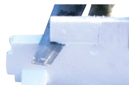
▲ 1 - Pose de la première poutrelle et des Isorupteurs Longitudinaux Repère de découpe pour le premier Isorupteur Longitudinal à l'angle de la construction.
