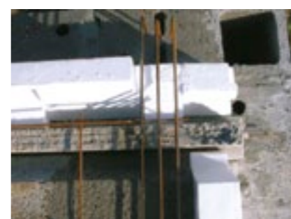
▲ 8 - Pose des armatures aux angles,
