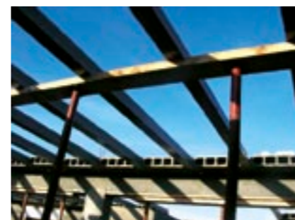
▲ 5 - Mise en place des étais
