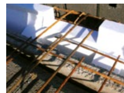
▲ Les armatures des chaînages seront mises en place suivant les règles de l'art. On veillera particulièrement à assurer le recouvrement des efforts dans les angles de la construction et au croisement des murs.
