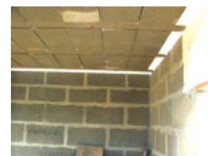
▲ Plancher Isorupteurs HB60 (vu de dessous).
