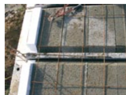
▲ en partie courante (sens transversal). Mettre en place les armatures de liaison. Forme, diamètre et nombre sont indiqués sur le plan de préconisation de pose KP1.
