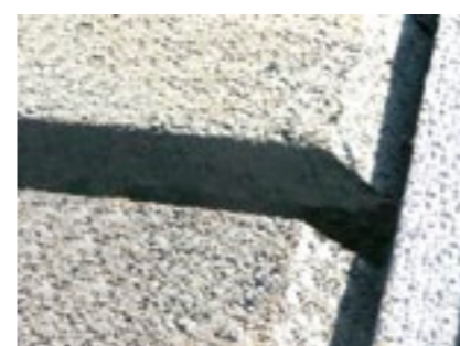
▲ Dans ce cas, veiller à utiliser une lisse de largeur adaptée pour pouvoir assurer le coffrage. Compléter le dispositif en utilisant deux hourdis borgnes au droit de(s) file(s) d'étais.
