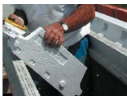
▲ Les valeurs '30', '40', '50' en face arrière des Isorupteurs correspondent à l'entraxe 30, 40 ou 50 cm entre poutrelles une fois la découpe suivant la rainure effectuée.
