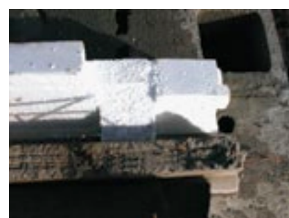
▲ Après la pose des Isorupteurs sur l'arase, ramener la poutrelle vers le mur extérieur de manière à assurer l'étanchéité au coulage.
