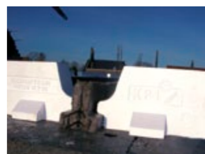
▲ S'assurer que les appuis de l'entrevous béton sur les talons des poutrelles sont suffisants (15 mm minimum). Si nécessaire, réduire la largeur du rupteur Transversal.
