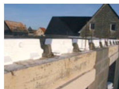
▲ 3 - Pose des Isorupteurs Transversaux En appui sur les deux poutrelles, ils seront utilisés comme gabarit de pose avec le 1 er entrevous béton.
