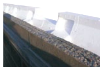
▲ 2 - Jonction de 2 Isorupteurs Longitudinaux : Un emboîtement précis garantit la continuité de l'isolation.
