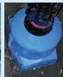
Le Drainkit doit être installé en terrain drainant afin d'éviter la stagnation de l'eau autour de la colonne.
