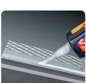
Assurer un recouvrement minimum de 5 cm entre chaque solin plomb et prévoir un débord de 5 cm à l'égout afin de rabattre ce dernier dans la gouttière.
