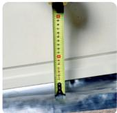
Effectuer un traçage au mur afin de bien positionner les solins plomb.
