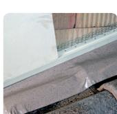
Déposer sur les tuiles tous les 35cm une noisette de mastic colle approprié,
