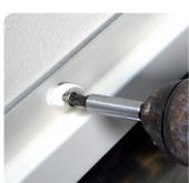
Utiliser les trous pré-percés pour fixer les solins plomb par le porte solin avec des chevilles et vis adaptées."
