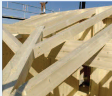
Jonctions poutres maitresses et secondaires
