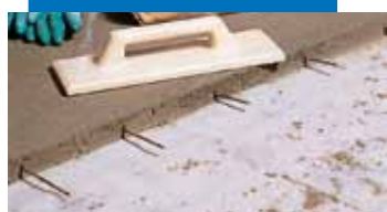
Chape Topcem avec fers de reprise
