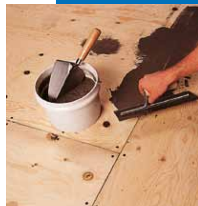
Application sur plancher bois de Nivorapid + Latex Plus
