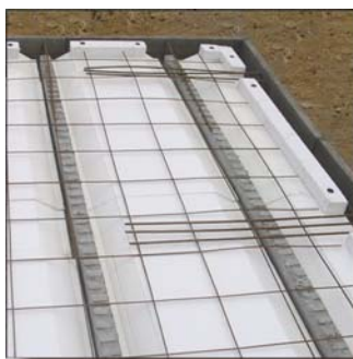
Plancher Hourdis Seoaboïs Rupteur Total : Stoptherm ES+EP
