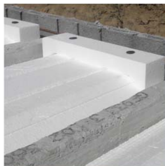
Plancher Hourdis Polystyrène Rupteur Total : Stoptherm EPT+
