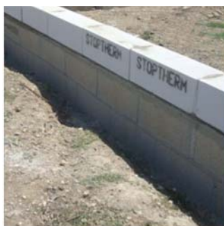
Plancher Seacwatt Rupteur Stoptherm Refend Bloc
