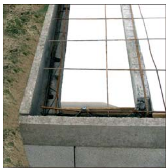
Plancher Hourdis Seoaboïs Rupteur Partiel : Stoptherm ES
