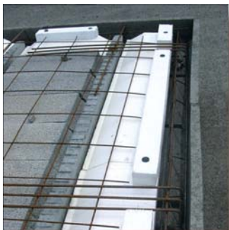
Plancher Hourdis Béton Rupteur Total : Stoptherm ES+EP
