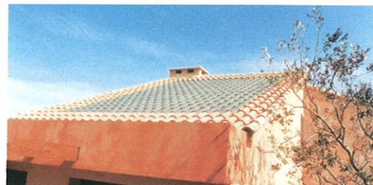
Exemple de toiture en tuiles de verre pour protéger des capteurs solaires
