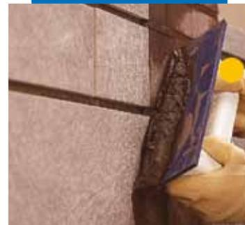
Autre exemple d'application d'**Ultracolor Plus** à la spatule en caoutchouc en mur
