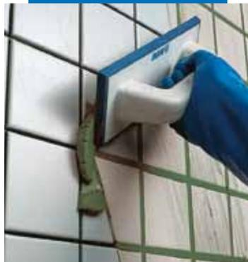
Jointoiment en mur avec la spatule caoutchouc
