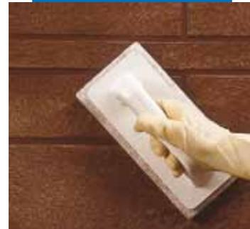
Nettoyage des joints en sol avec le scotch Brite (sur produit partiellement durci)
