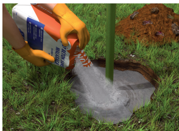
2 - Verser le béton - Positionner l'objet
