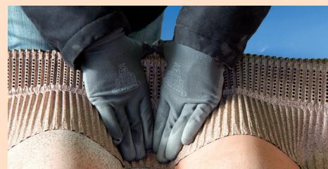
4. Fixer les tuiles faîtières sur les Closoirs rouleau souples Aluminium à l'aide de vis ou clips de faîlage appropriés.
