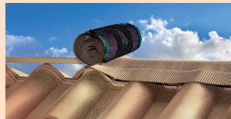
2. Dérouler et fixer les Closoirs rouleau souples Aluminium sur la rehausse en assurant un recouvrement minimum de 5 cm entre chaque closoir.
