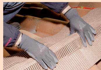
3. Enlever le film de protection du butyl et mater l'aluminium du haut vers le bas du galbe des tuiles. Exercer une pression suffisante pour permettre au butyl d'adhérer aux tuiles à l'aide d'un maillet type bois/pvc ceci, afin d'optimiser l'adhérence du butyl en période de grand vent (température de mise en œuvre comprise entre +5°C et +40°C sur support sec et propre). L'aluminium doit parfaitement épouser la forme des tuiles.
