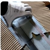
Poser les CLOSOIRS RIGIDES PROFAÎT® PLOMB sur les liteaux en assurant un recouvrement minimum de 5 cm entre chaque closoir (l'encoche située à l'extrémité des closoirs est un repère visuel rapide du recouvrement minimum à respecter).
