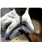
Déposer et fixer les tuiles faîtières sur les closoirs à l'aide de vis ou de clips de faîtage appropriés. Le sens de recouvrement des tuiles faîtière doit être opposé au vent le plus dominant dans l'axe du faîtage.
