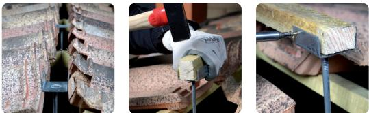
Fixer les supports de lisse (dit « clou porte liteau ») sur la charpente et fixer les liteaux sur ces derniers.
