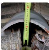
Pour déterminer la hauteur de la lisse de rehausse, mettre en position une tuile faîtière et mesurer la distance pour que les extrémités de cette dernière soient tangentes aux tuiles de plain carré.
