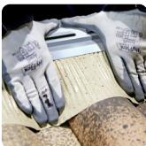
Matez le plomb du haut vers le bas du galbe des tuiles. Le plomb doit épouser parfaitement la forme des tuiles.
