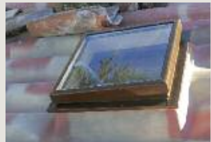
Pose de la fenêtre de toit
