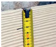
③ Recouvrement de 30 mm
