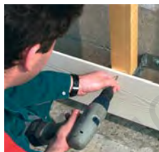
② Pose et fixation de la première rangée de clins
