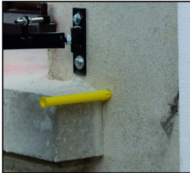
Percer la maçonnerie et insérer la cheville grande longueur.
