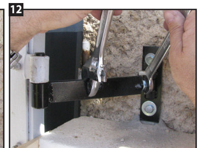
12 Si besoin, on peut redresser le gond en dévissant l'écrou zingué (clé de 17) et en faisant bouger le fer plat à l'aide d'une clé à molette.
