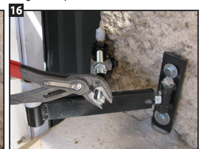
16 Serrer la tige filetée sur l'ancien gond à l'aide d'une pince.
