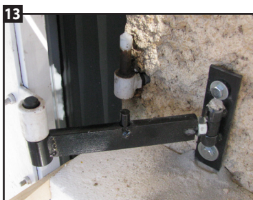
13 Le corps de gond est en place.
