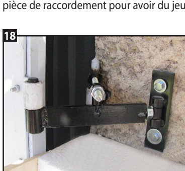
18 Le gond I.N.G. ISO est mis en place, il ne reste plus qu'à l'isoler.
