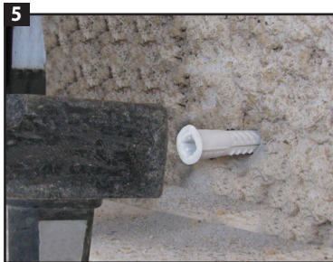
5 Enfoncer la cheville blanche à l'aide d'un marteau.
