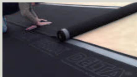
Collage des recouvrements avec les deux bords autocollants intégrés
