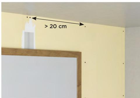
Pour limiter les risques de fissuration, les joints entre les plaques de plâtre doivent être à plus de 20 cm des montants verticaux de l'huissérie.
