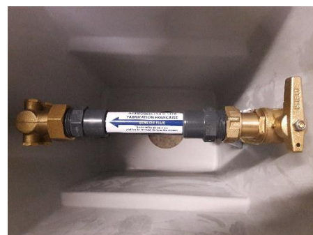
Montage pour compteur DN15 lg 170 mm
