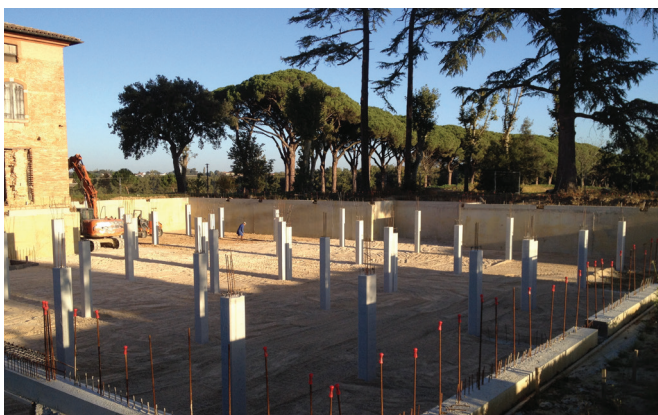
VUE POTEAU FINI
